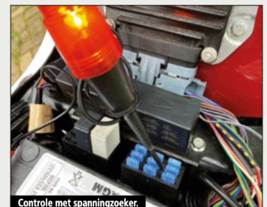
Controle met spanningzoeker.
